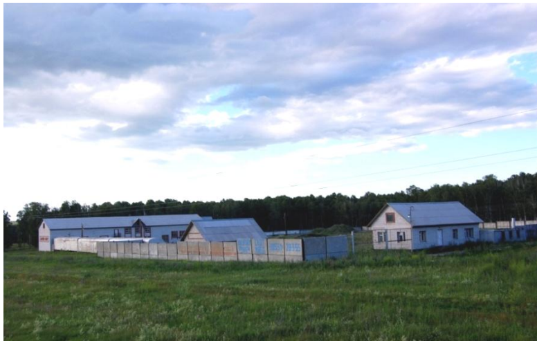
Общий вид имущественного комплекса.
